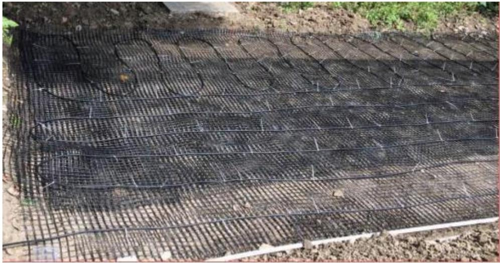
图 地埋振动光纤方式
